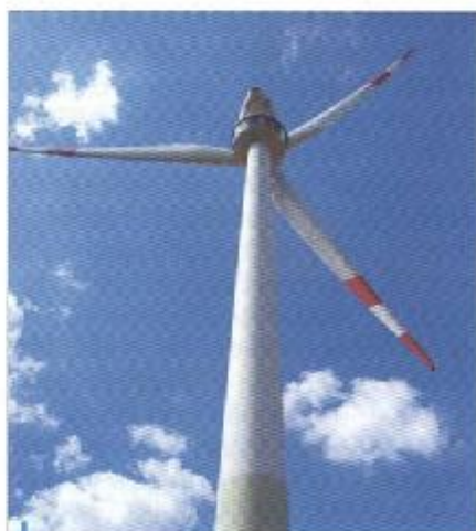
Větrná elektrárna Enercon 2 MW s průměrem rotoru 80 m v Krušných horách
